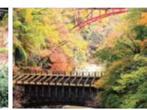
▲ハツ沢発電所一号水路橋
