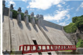
▲下から見るダム
