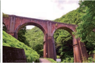
▲ 碓氷第三橋梁(めがね橋)
