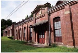
▲ 旧丸山変電所
