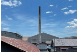
▲ 煙突 高さ37.5m 直径2.5m
